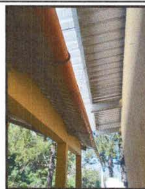
Foto 4: Se sustituirán los tubos pvc por canales de metal. Es prioridad para un mejor abastecimiento de agua, para uso de los alumnos.
