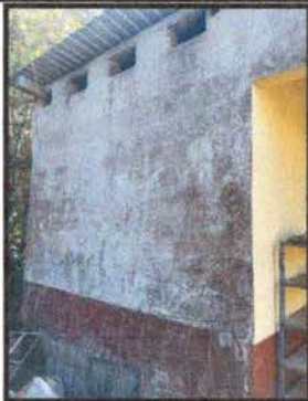
Foto 17: REPARACION O SUSTITUCION DE AREA COCINA
