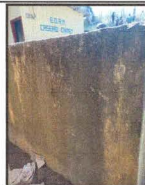
Foto 16: Exterior de la cisterna.
