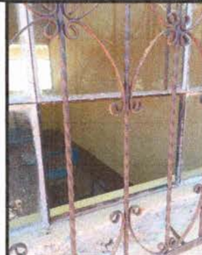
Foto 2: Se cambiarán vidrios que estan en mal estado
