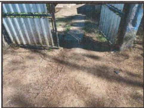
Foto 5: CUNETAS DE CONCRETO:
