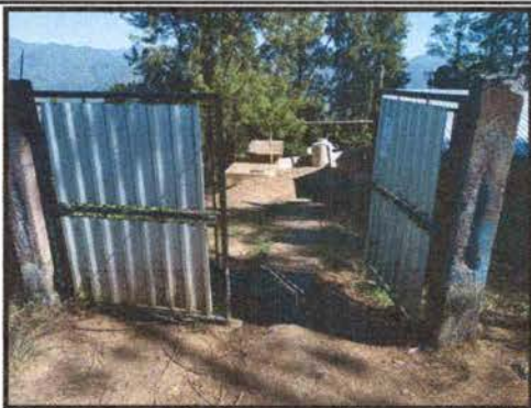
Foto 9: MANTENIMIENTO A PORTON PRINCIPAL
