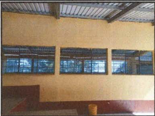
Foto1: VENTANAS: Para mayor protección se colocará balcon.
