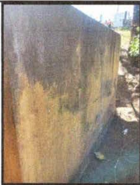
Foto 15: REPARACION Y MANTENIMIENTO DE CISTERNA DE AGUA
