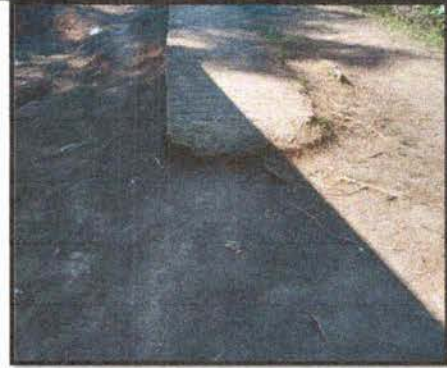
Foto 14: Urgente construcción de rampa de acceso.
